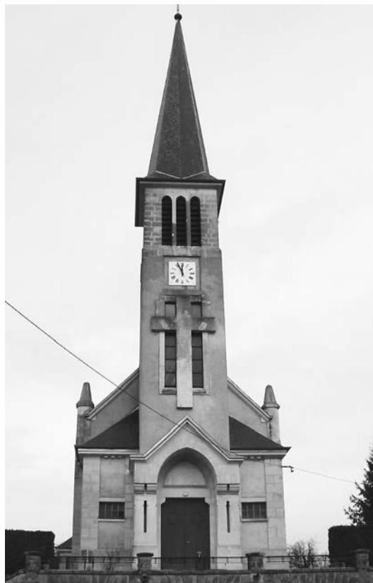
7.6 L'église de Bures, reconstruite au début des années 1920, dans un style qui nous semble plus proche du néo-gothique que du gothique médiéval, tout en présentant des détails incongrus (comme par exemple la grande croix au-dessus du porche). [Photo de l'auteur]
