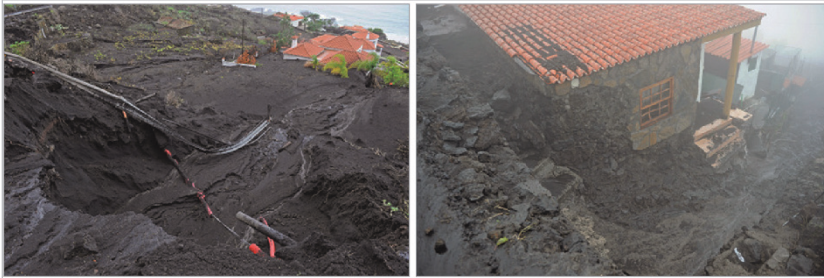
Abb. 2 Zerstörung von Infrastruktur und Gebäuden durch Muren (bzw. Lahare) als Folge der Starkniederschläge im Dezember 2009 auf der Brandfläche im Süden der Insel
