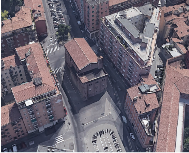
FIGURE 7.7 Church of Santa Maria della Visitazione al Ponte delle Lama.
